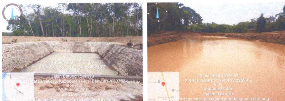
Gambar 10. Pembuatan Embung Pertanian
